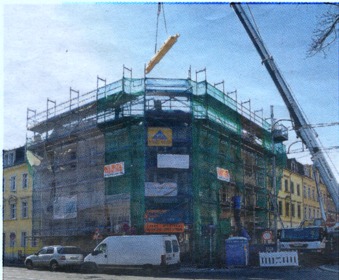
DER NEUE BALKEN für den Dachstuhl wird eingehoben. Foto: Naumann
